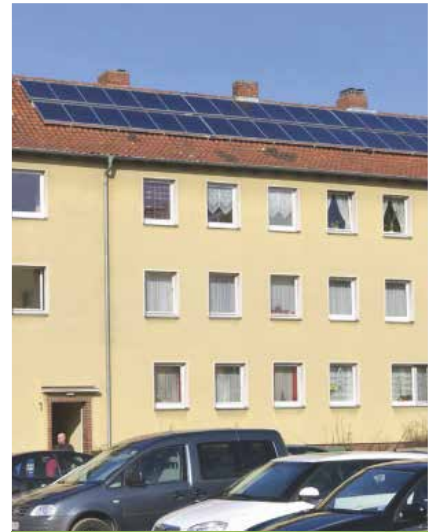
Solaranlagen Neue Knochenhauerstraße
