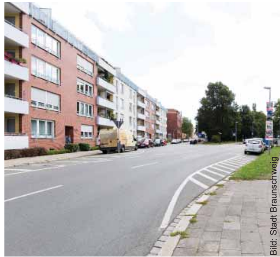
Der Knotenpunkt vor der Umgestaltung
