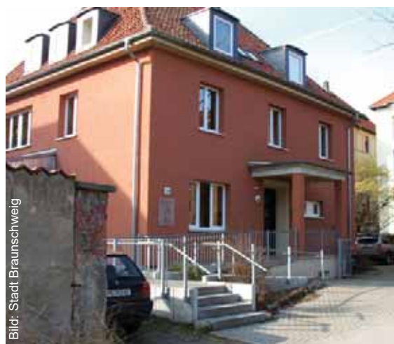
Der Madamenhof vor und nach der Sanierung
