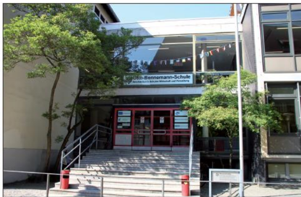
Auch die Otto-Bennemann-Schule steht auf der Sanierungsliste der Stadt.
